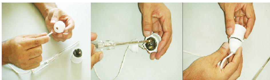
شکل (۲-۱۴) مراحل اتصال هولدر
