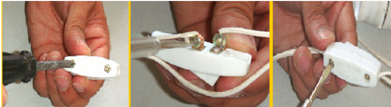
شکل (۲۲-۲) مراحل نصب سوئیچ در امتداد سیم چراغ سیار
